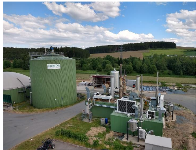
Bild oben: BHKW-Park mit insgesamt 7 BHKW und ca. 3,3 MW Leistung (in laufender Erweiterung auf 9 BHKW)
